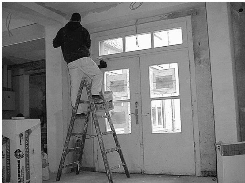
Renovierungsarbeiten in der Burgstraße
