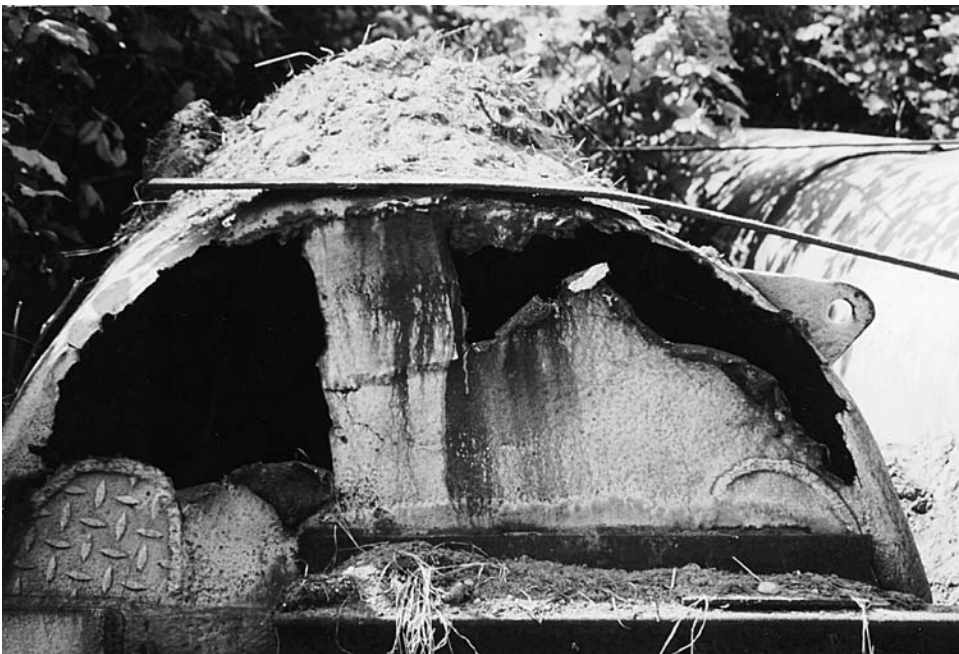
Ponton auf der Halbinsel im Banter See, Wilhelmshaven
